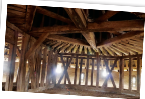
Remarquable charpente en chêne de la Tour Zizim.
