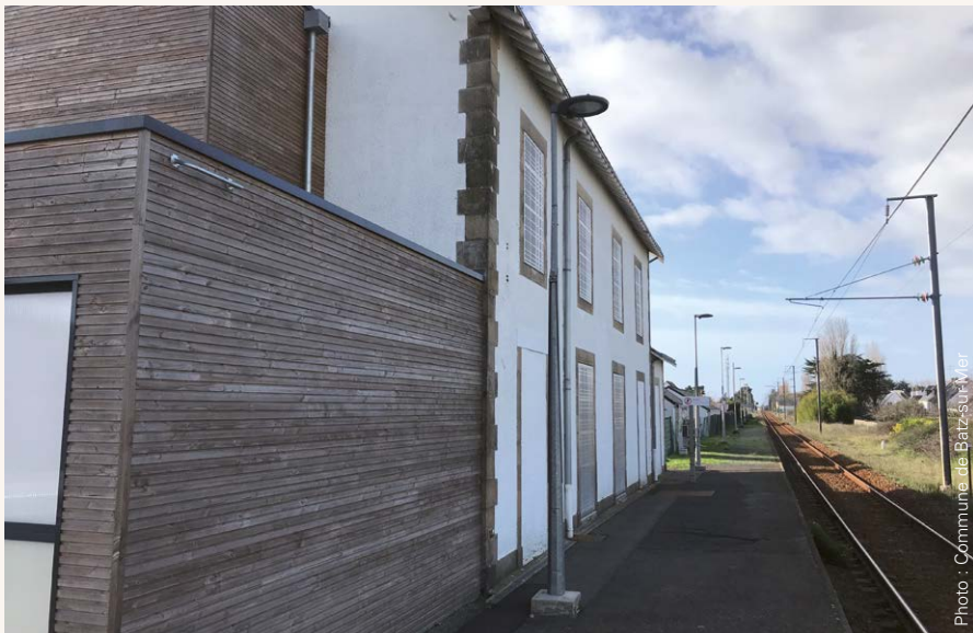
↑ Façade arrière du centre de santé, 2022.
