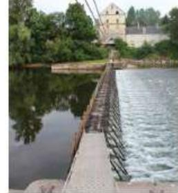
Il est l'un des 16 barrages construits entre 1836 et 1862 au long du Cher. Ils sont tous constitués d'un système d'aiguilles de saignées qui sont plaquées par le courant contre un tablier métallique et dont le nombre règle le débit de la rivière. Sur l'autre rive, on peut voir un ancien moulin. Pour y accéder, longe le Cher sur le quai de la République et, arrivé au virage, poursuivez sur le chemin de balage.
